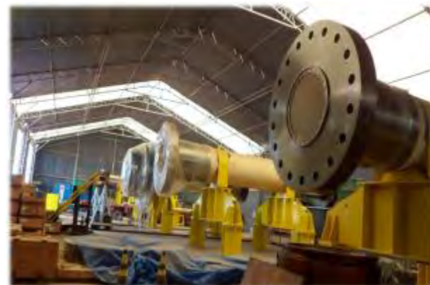
Galpão de pré-montagem da margem direita – eixos das turbinas
