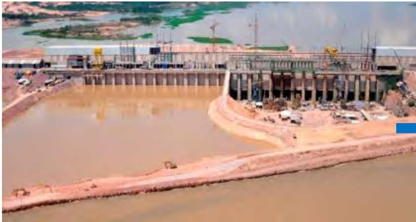
Casa de força da margem direita – vista de jusante (out/13)
