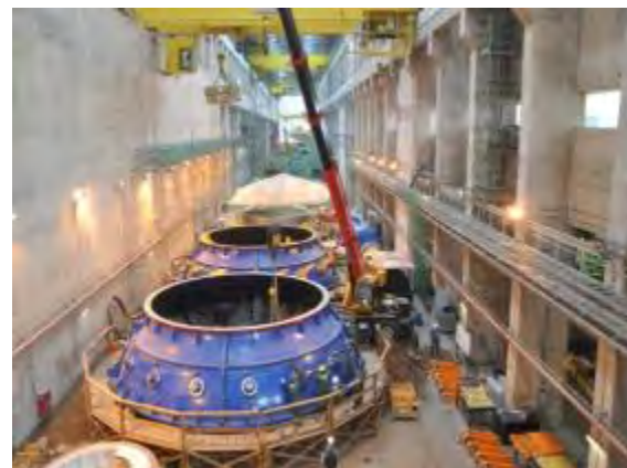
Área de montagem 1 da casa de força da margem direita – distribuidores
