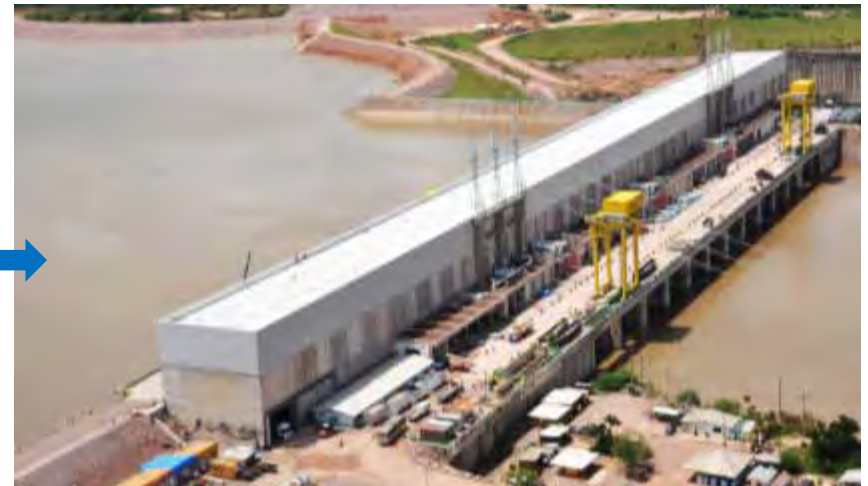
Casa de força da margem esquerda – vista de jusante (jan/14)
