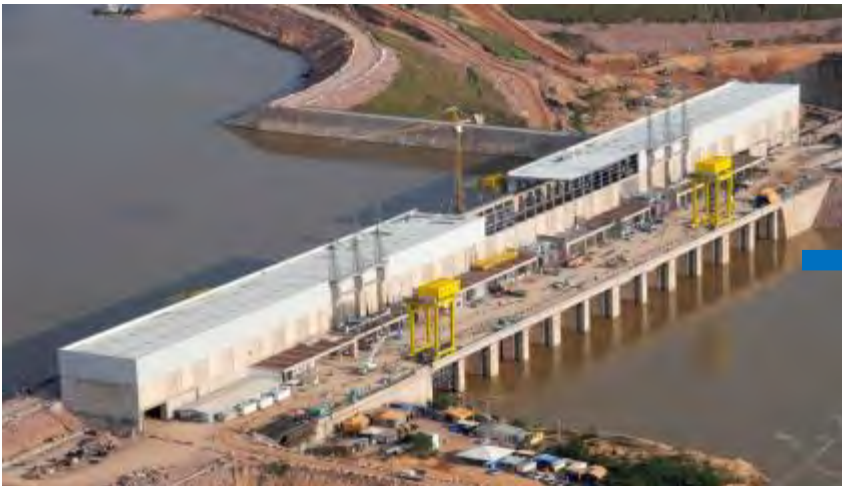
Casa de força da margem esquerda – vista de jusante (set/13)
