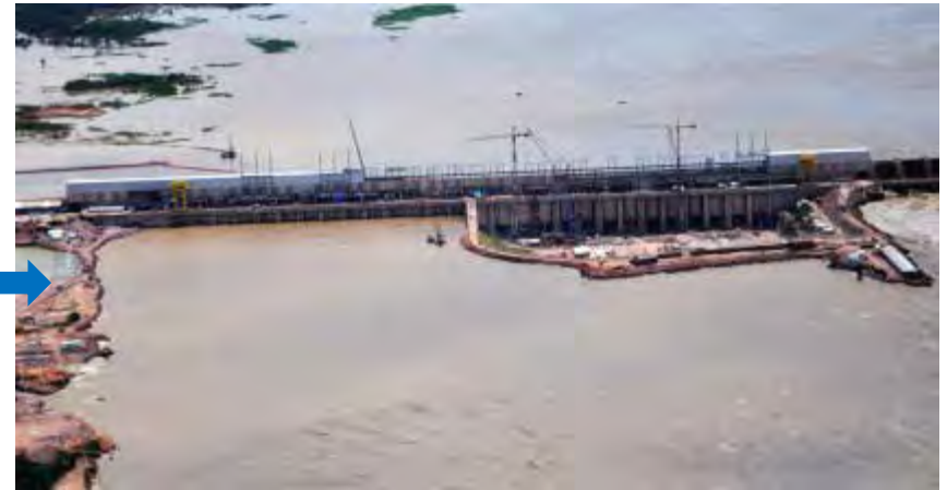
Casa de força da margem direita – vista de jusante (jan/14)
