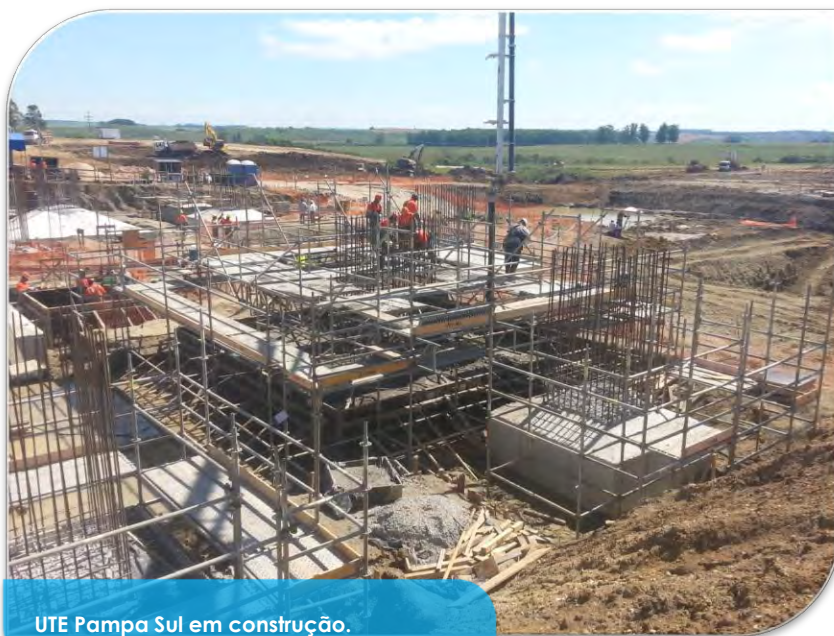
UTE Pampa Sul em construção.
