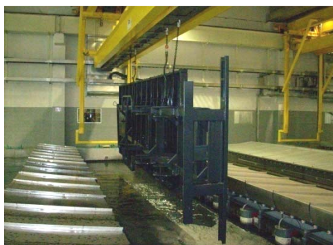
Pintura E-coat – Randon Implementos
