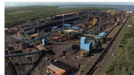
Terminal de Cargas - TECAR
