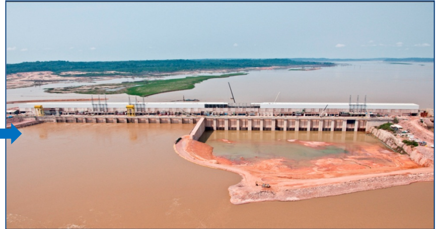
Casa de força da margem direita – vista de jusante (out/14)
