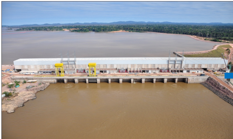
Casa de força da margem esquerda – vista de jusante (jun/14)
