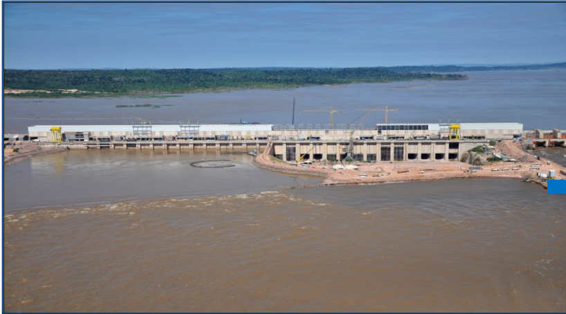
Casa de força da margem direita – vista de jusante (jun/14)
