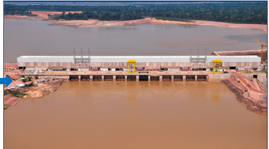
Casa de força da margem esquerda – vista de jusante (out/14)
