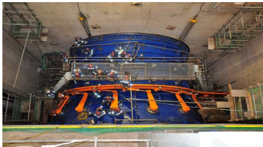
Casa de força da margem direita (UG 06 - 100% montada) (out/2014)
