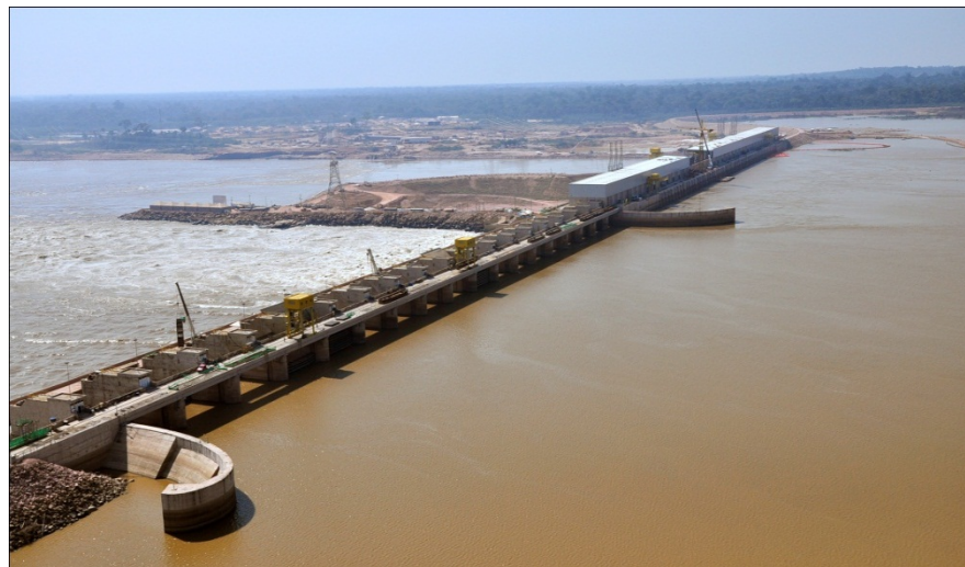
Vertedouro e casa de força da margem direita – vista de montante
