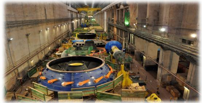
Área de montagem da casa de força da margem direita (Jan/2015)
