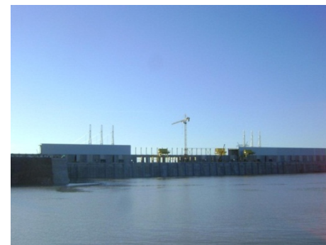
Casa de força – margem esquerda – vista de montante
