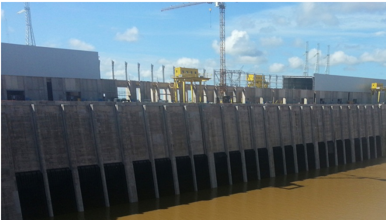
Casa de força – margem esquerda – vista de montante
