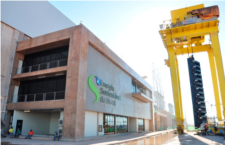
Área de montagem e edifício de controle – margem direita
