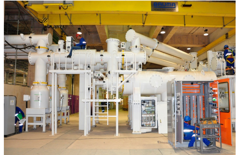
Galeria – casa de força – margem esquerda
