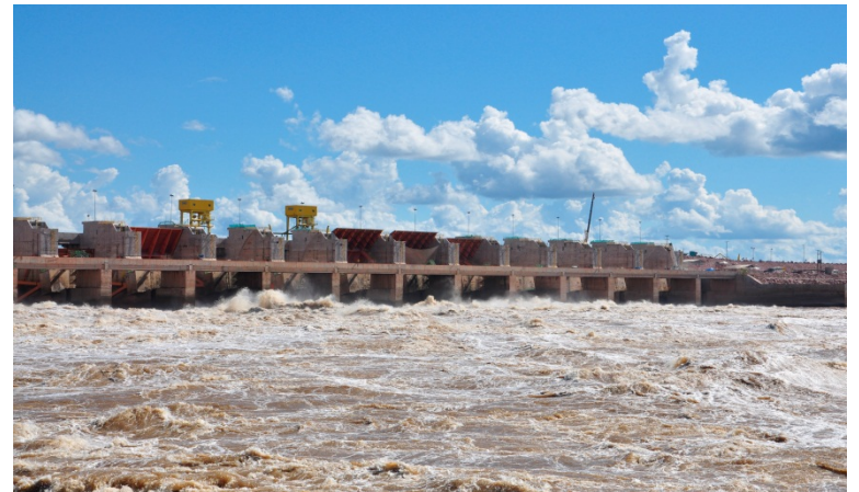
Vertedouro – vista de jusante
